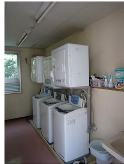
洗濯室 Laundry Room
