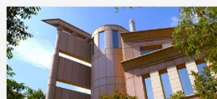
Building 3 - Av. Esplugues
